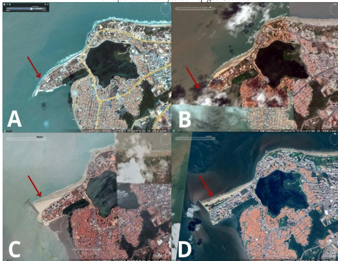
Figura 2 – Evolução da Erosão Costeira na Praia de Ponta D'Areia e as etapas da construção do Espigão Costeiro. As setas vermelhas indicam a área da faixa de areia. A. Imagem de novembro de 2004, antes da obra. B. Imagem de setembro de 2011, no início das obras. C. Imagem de novembro de 2014, após a entrega das obras. D. Imagem de maio de 2023, mostrando a evolução ao longo de 9 anos após a finalização da construção do Espigão Costeiro.
