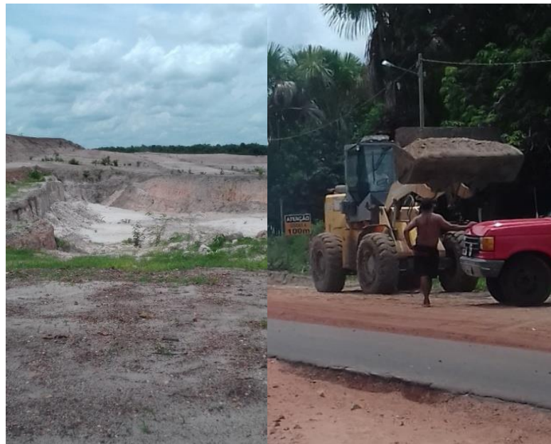
Figura 14 – Desmatamento e erosão no Residencial Vale do Sol.
