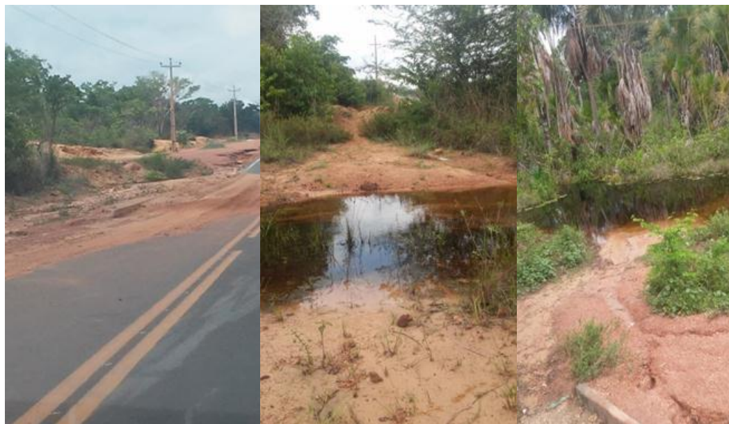
Figura 21 – Erosão e assoreamento na APA do Inhamum.
