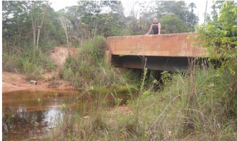
Figura 3 – Ponte da Rodovia MA-127 sobre o Riacho Inhamum.
