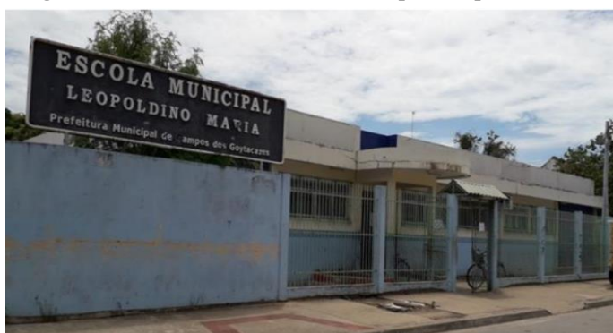
Figura 1 – Fachada da Escola Municipal Leopoldino Maria.
