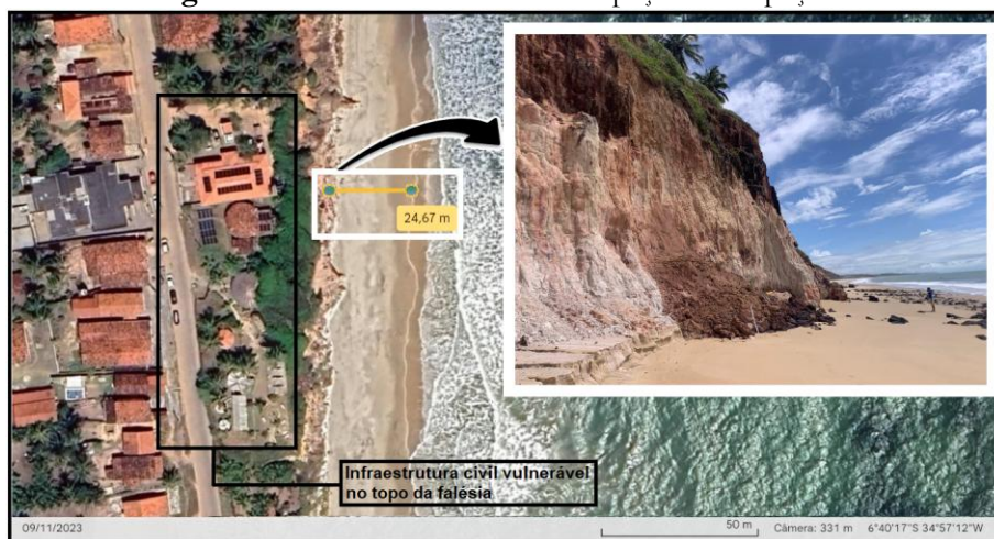
Figura 2. Trecho de falésia com ocupação em espaço vulnerável.
