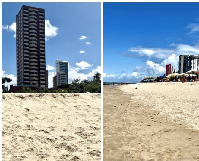
Figura 4 e 5 – Escarpas de Erosão na Praia de Candeias
