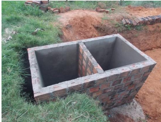
Figura 1 - Construção da fossa séptica prismática retangular com duas câmaras em série.
