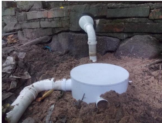
Figura 2 - Instalação da caixa de gordura na saída do encanamento da cozinha.
